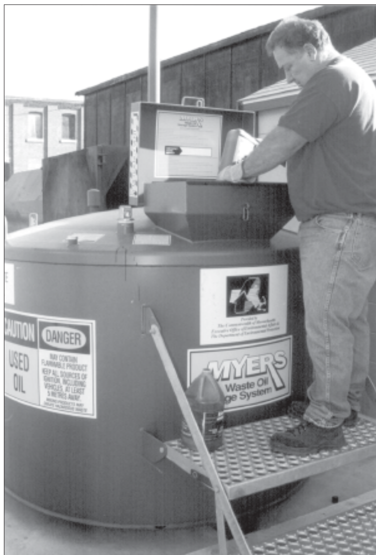
Gordon Baffney, vaciando aceite de motor usado en el nuevo tanque de recolección instalado en el patio del D.P.W.
