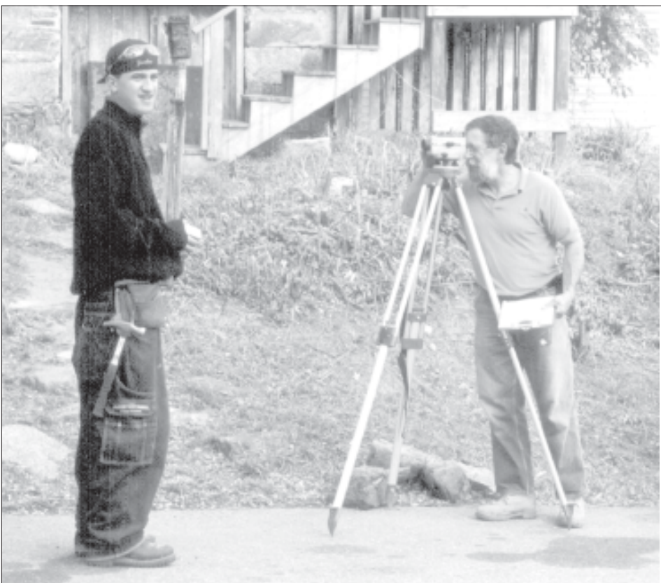
El proyecto de construir la rampa comienza con la toma de medidas. Aquí aparecen Emerson Dahmen de Youth Build siendo auxiliado por Antonio Cruz.
