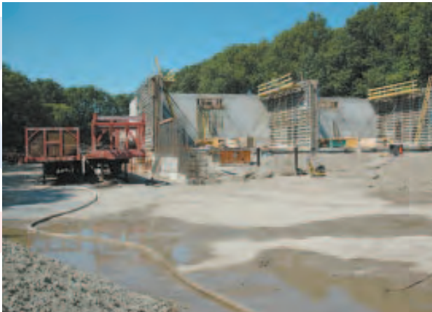
First Water Treatment Plant in 70 years La primera planta de tratamiento de agua en 70 años
