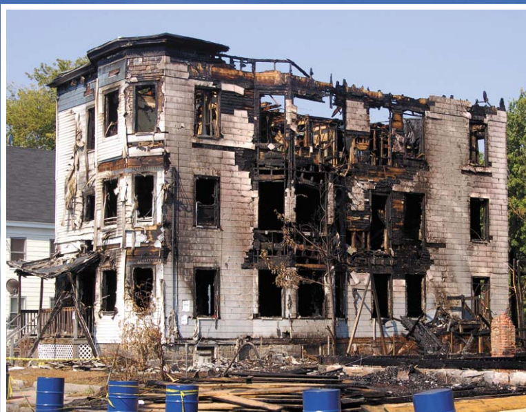
Estado en que quedo la casa de la calle Andover después del fuego y que acaba de ser demolida.
