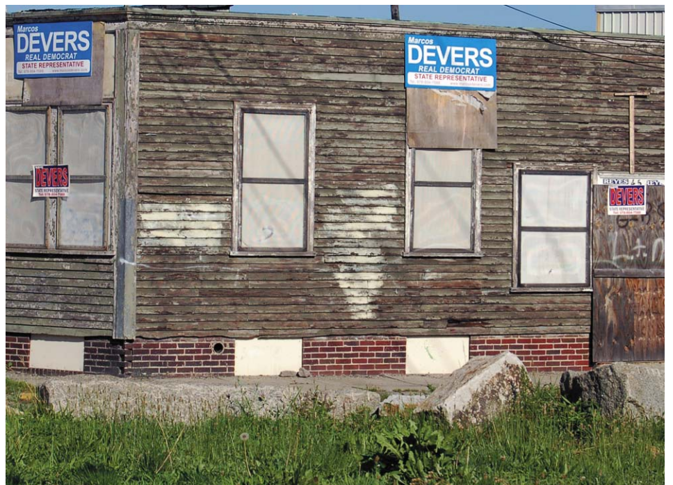
Hay regulaciones acerca de colocar letreros en edificios abandonados, cubiertos con planchas de madera, o inhabitados; así todo, usted puede ver estos letreros en la esquina de las calles Melrose y Medford. Este edificio ha sido utilizado en el pasado por muchos políticos que dejan sus letreros desteñirse mucho después de pasadas las elecciones. Foto tomada el miércoles, 16 de julio, 2008 a las 5:11 P.M.
