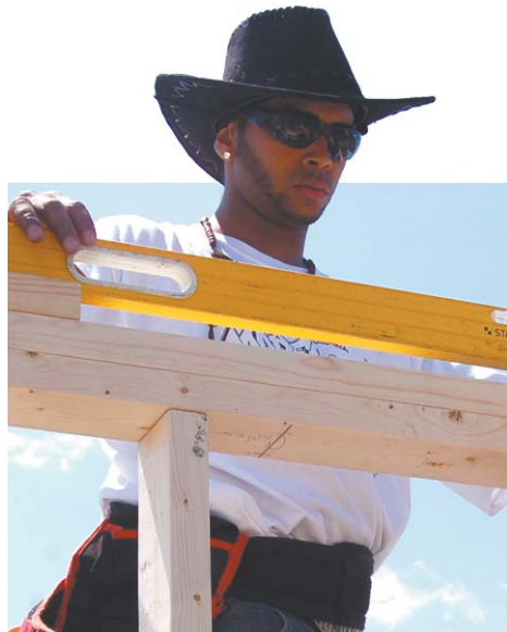
José Martínez comprobando el nivel de la estructura.
