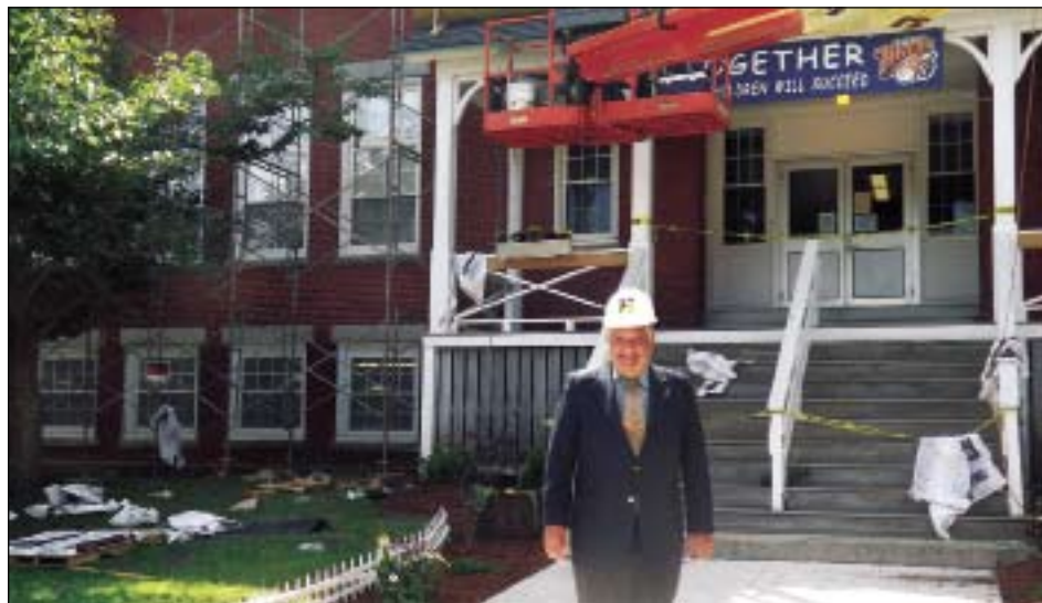
El Alcalde James J. Fiorentini frente a la Escuela Primaria Tilton mientras instalaban el nuevo techo.
