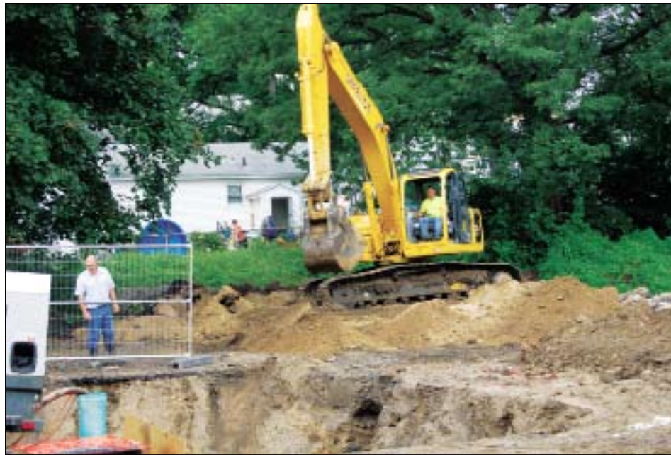
Equipo pesado escarbando en un lote vacío detrás de la casa de Burgos como parte del trabajo que se está realizando en el área.
